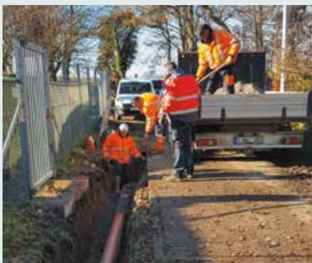
Création d'un fossé et pose de tuyaux à Fraiture
