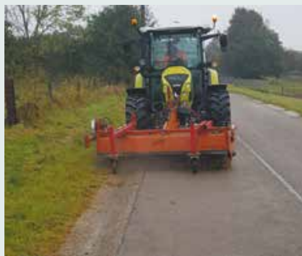
Nettoyage des filets d'eau
