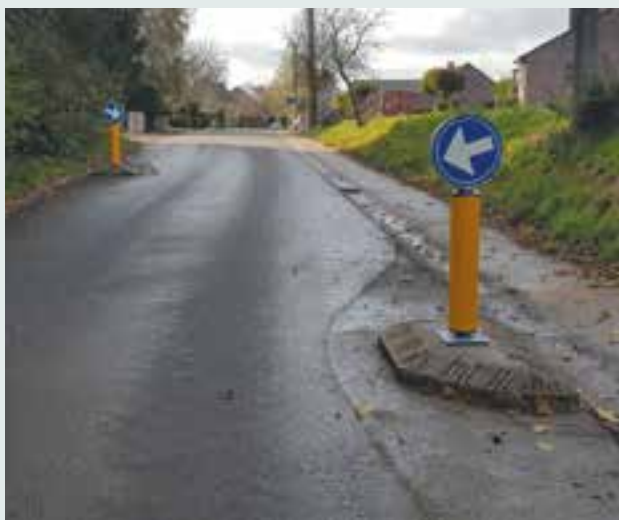
Remise en état des panneaux de signalisation
